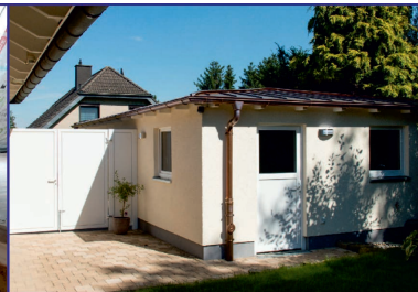
Garage mit Abstellraum im Holzrahmenbau
