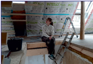
Dach- u. Innenausbau
