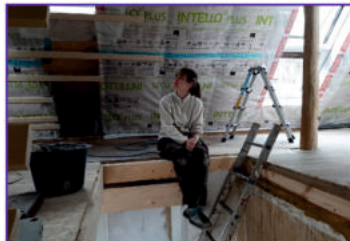
Dach- u. Innenausbau
